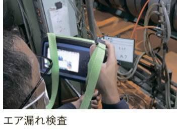
エア漏れ検査
