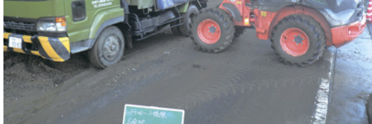
崖崩れ復旧作業
