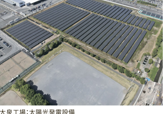
大泉工場:太陽光発電設備
