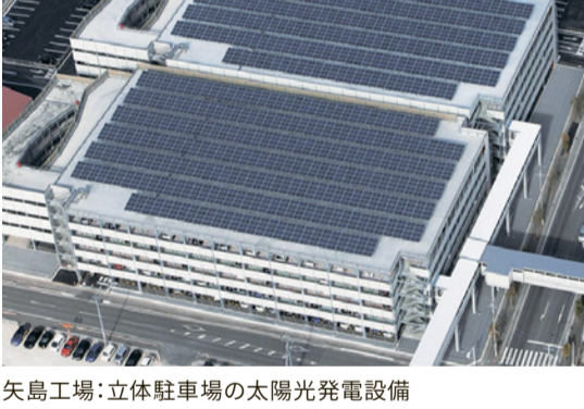
矢島工場:立体駐車場の太陽光発電設備
