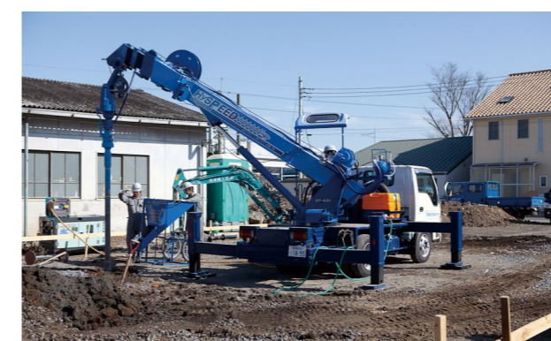
HySPEED 工法 施工風景
