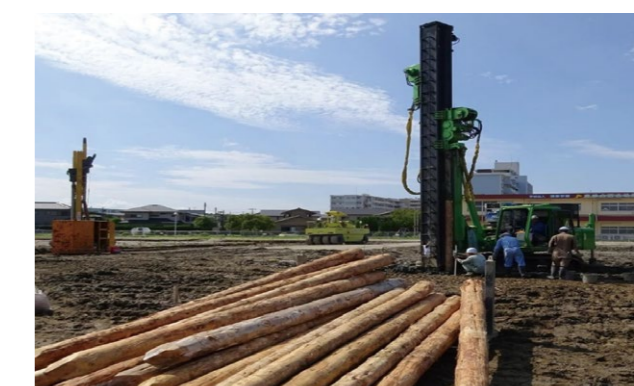
カーボンストック工法 施工風景 ※木材活用地盤対策研究会より提供
